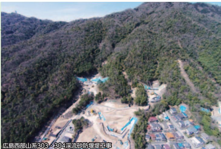
広島西部山系303・304溪流砂防堰堤工事
