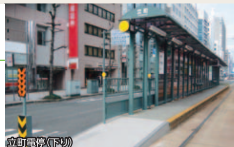
立町電停(下り)
