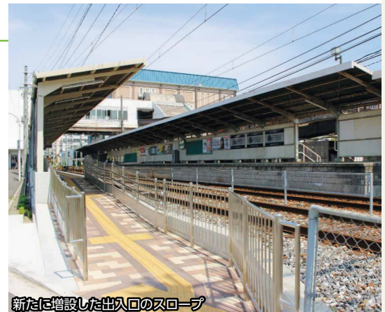
新たに増設した出入口のスロープ
