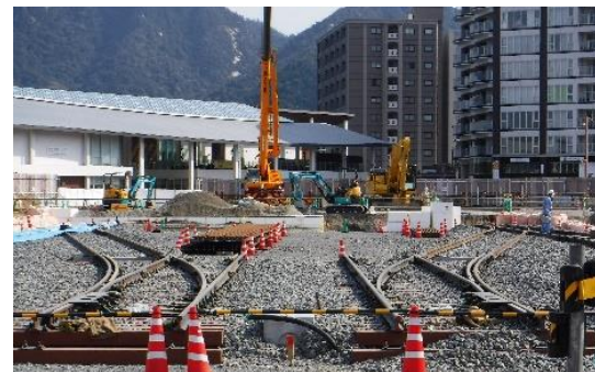
▲広電宮島口駅軌道移設工事（2021年4月撮影）
