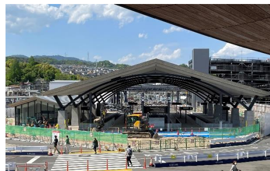
▲広電宮島口駅新駅舎工事(2022年5月撮影)
