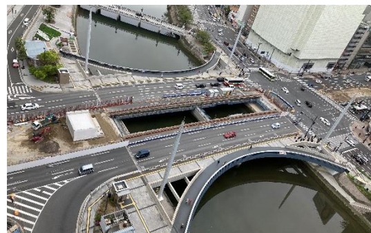
▲ 広島駅前大橋ルート整備事業（2023年4月現在）
