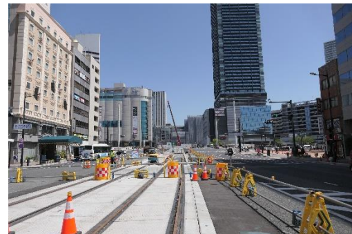
▲広島駅前大橋ルート整備事業（2024年3月現在）
