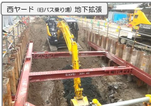
地下拡張部 掘削作業中
