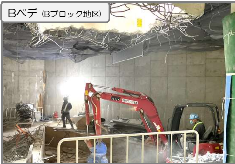
Bペデ (歩道橋) 地下部で杭の準備作業中
