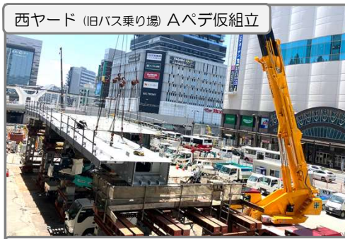
Aペデ (歩道橋) 橋桁を地上で仮組立作業中
