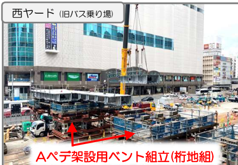
Aペデ 西ヤード内 橋桁組立状況
