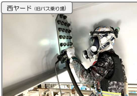
Aペデ 大州通り用橋桁 ボルト締め・塗装状況
