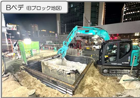
Bペデ(歩道橋) 既設構造物取壊し作業中
