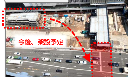
Aペデ(歩道橋) 橋桁組立状況
