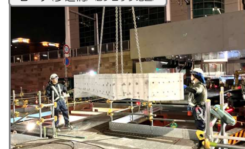
上床版(地下部天井部) 撤去作業中
