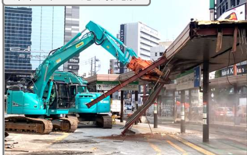
旧広電広島駅電停施設 解体中
