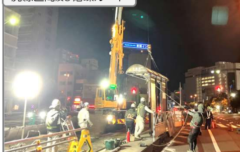
旧電停等を解体し循環ルートの整備を開始
