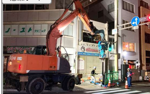
道路拡幅(照明柱移設 基礎工事) 施工中
