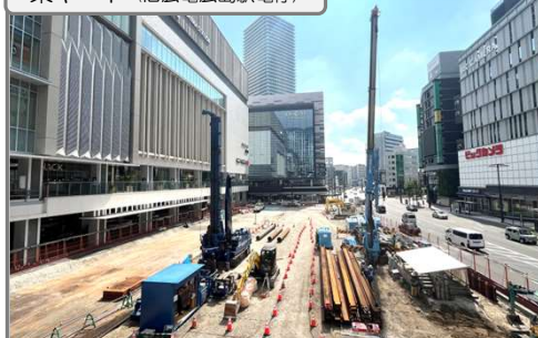
Bペデ(歩道橋) 杭工事他施工中
