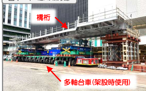
Aペデ(歩道橋) 橋桁架設準備中
