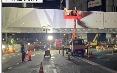
橋桁側面ラッピング貼付け
