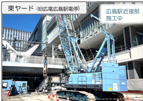
Bペデ(歩道橋) 杭施工箇所支障物撤去中
