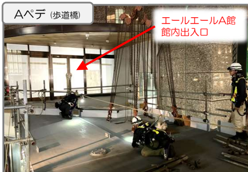
エールエールA館側接続部 橋桁架設
