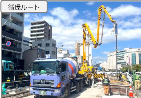
的場町新設電停基礎部 コンクリート打設中
