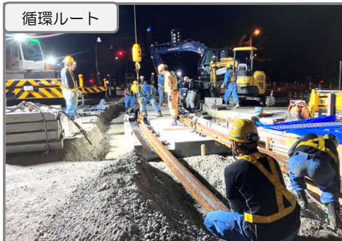
的場交差点 新設軌道施工中
