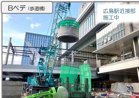
Bペデ 杭工事を施工中
