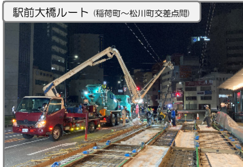
軌道部のコンクリート舗装施工中
