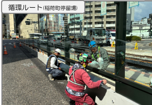
停留場 上屋付属物 施工中
