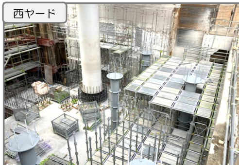
地下拡張部の上床版(天井) 施工中
