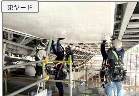
大屋根地組み(パネル設置) 施工中
