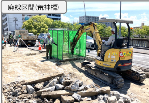
路面電車部分の補強工事 既設床版取壊し中
