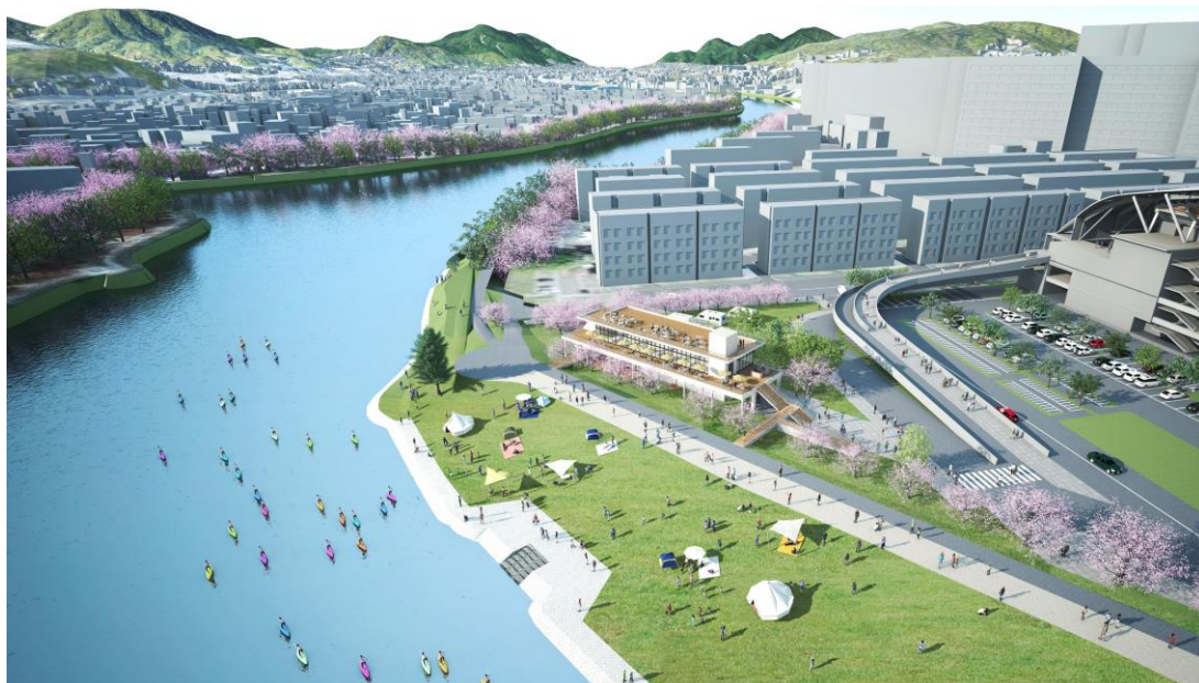
基町環境護岸および西側広場エリアを臨む
