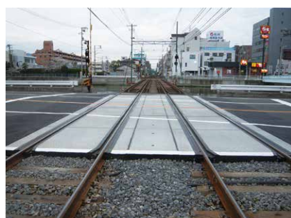
踏切道重レール化工事
